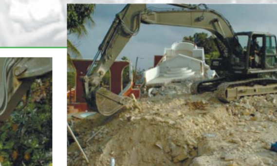
重機による作業
