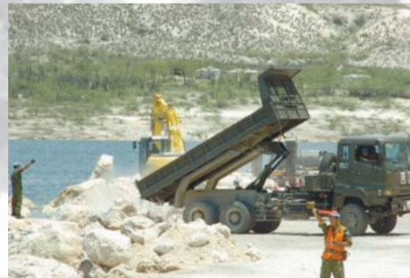
交通統制のもと碎石を卸す
