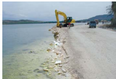
ドミニカ国境道補修 左は実施前、右は実施後
